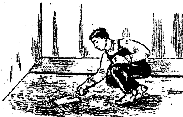
Выравнивание и сглаживание мозаичного покрытия
