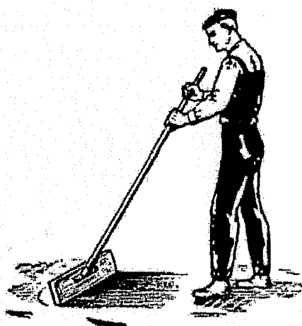
Удаление шлама при оттирке и шлифовке пола
