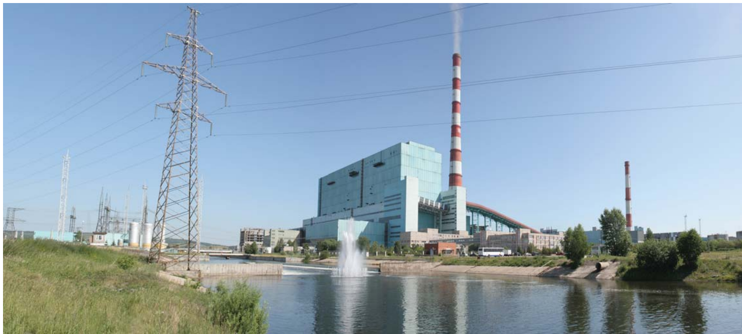
Дымовая труба Березовской ГРЭС является самой высокой трубой в России и 5-й по высоте в мире.
