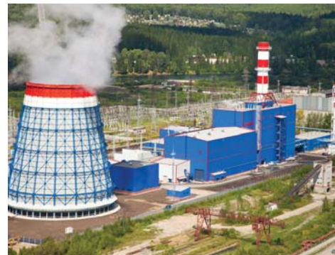
Благодаря вводу нового энергоблока мощность Яйвинской ГРЭС выросла более чем на 70%
